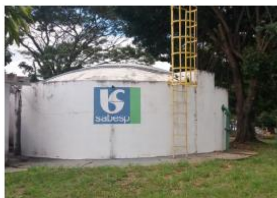
Vista do reservatório apoiado do Distrito de Santa Terezinha
