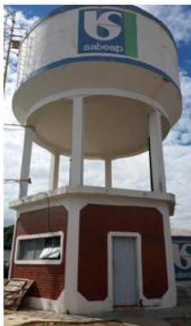
Vista do reservatório elevado de Lupércio - Sede
