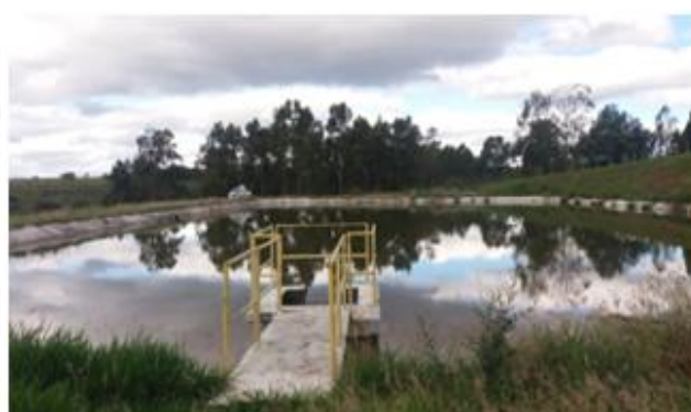
Vista da ETE do Distrito de Santa Terezinha
