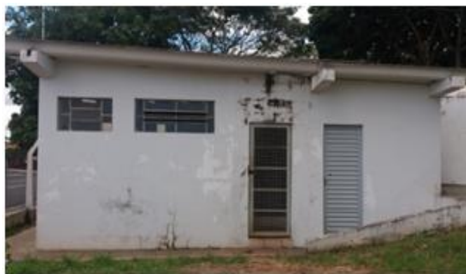
Vista do local da sala de dosagem e do booster do Distrito de Santa Terezinha
